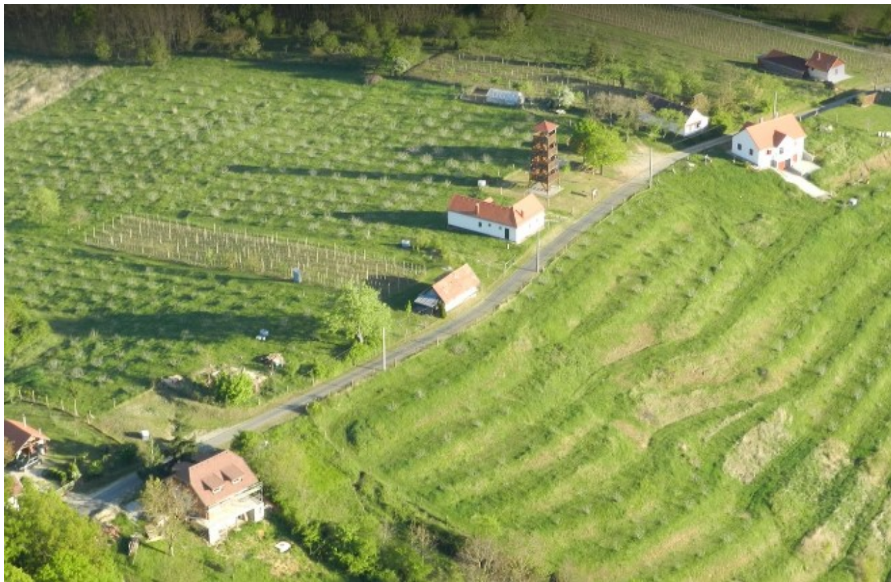
A kilátó építménye az elbontás előtt
